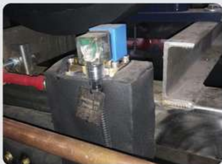
5 - Жидкостной эжектор Danfoss в составе агрегата
